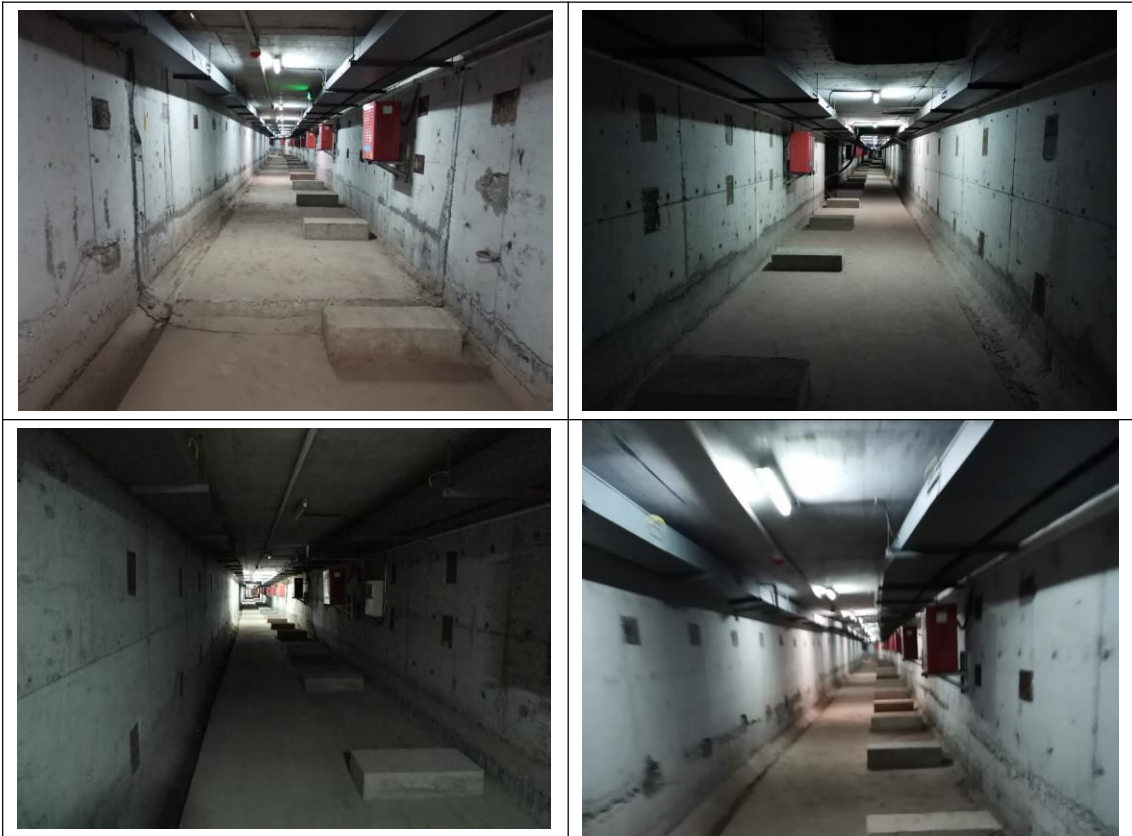
管廊仓体内排水设施调查
